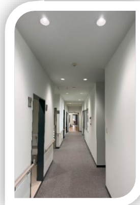
ろうか かべとそう しょうめい 廊下の壁塗装、LED照明
