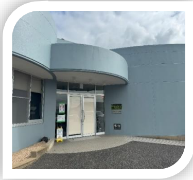
がいへき ほしゅう とそう 外壁の補修、塗装
