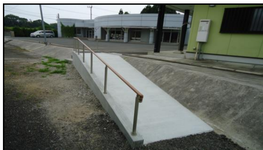
通所施設(のぞみ園直方)との間のスロープ
